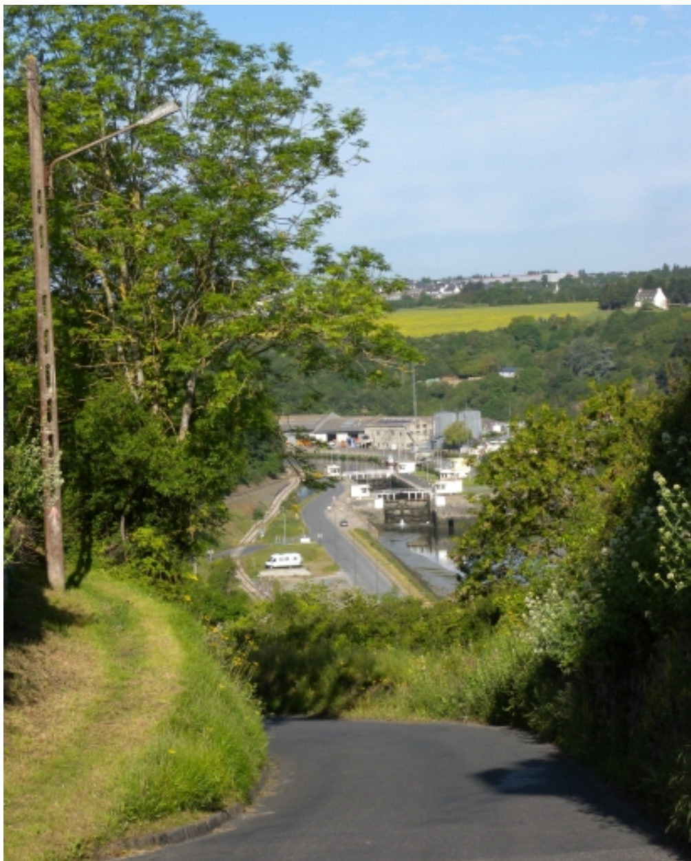
Vue en aval de l'écluse du premier bassin à flot
