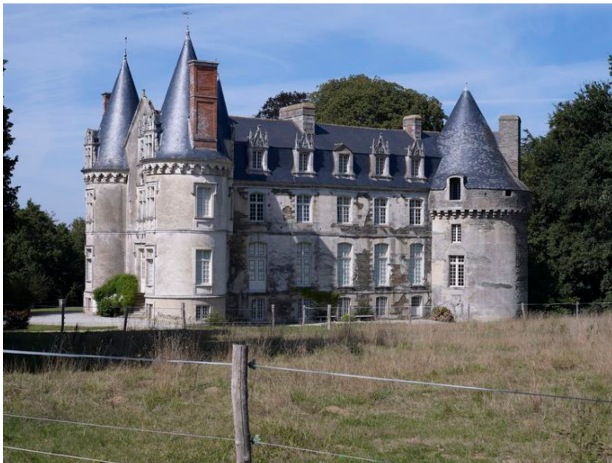
Château vu du sud-ouest (état en 2010)
