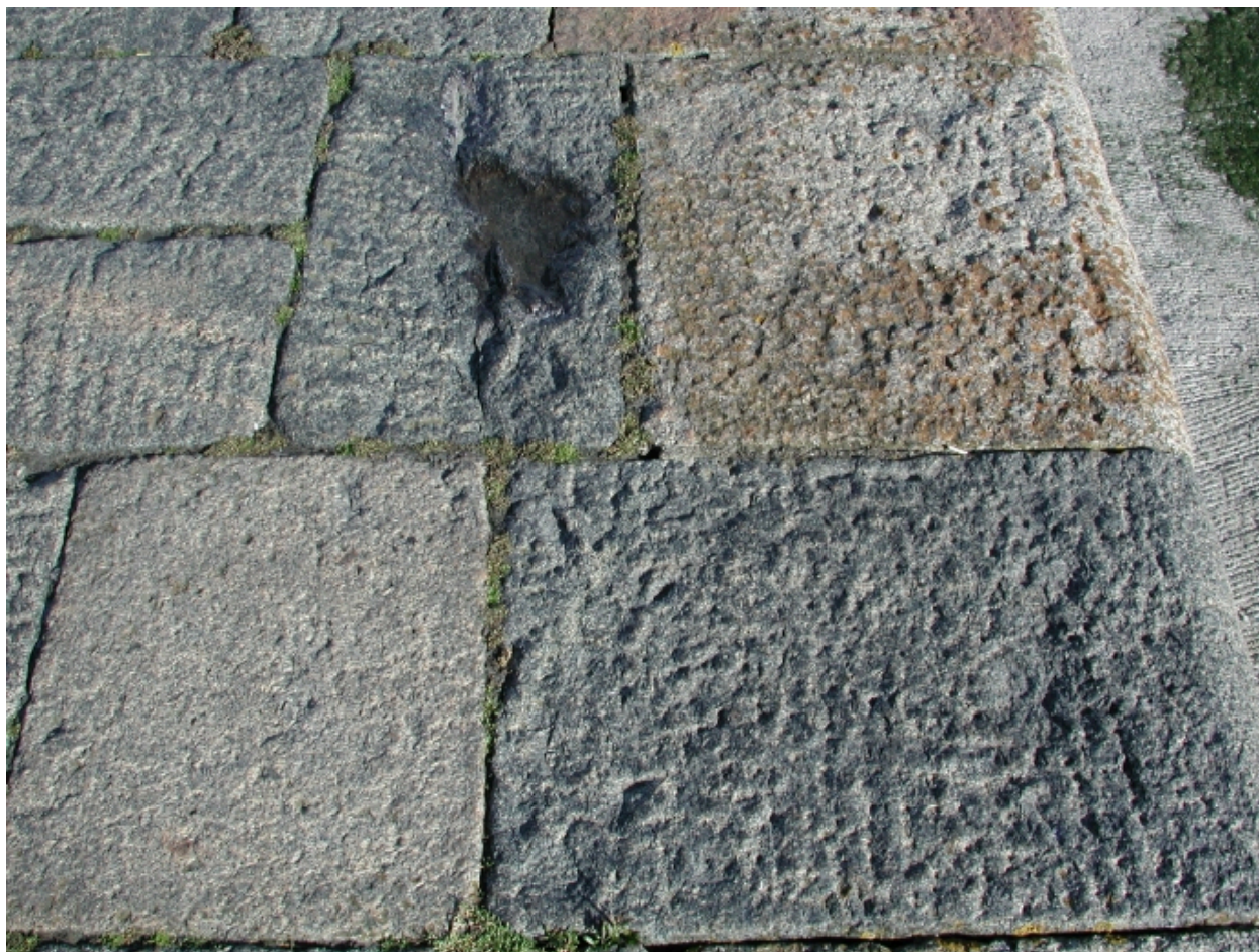
Vue de la disposition des pierres de recouvrement en granit gris et rose bouchardé
