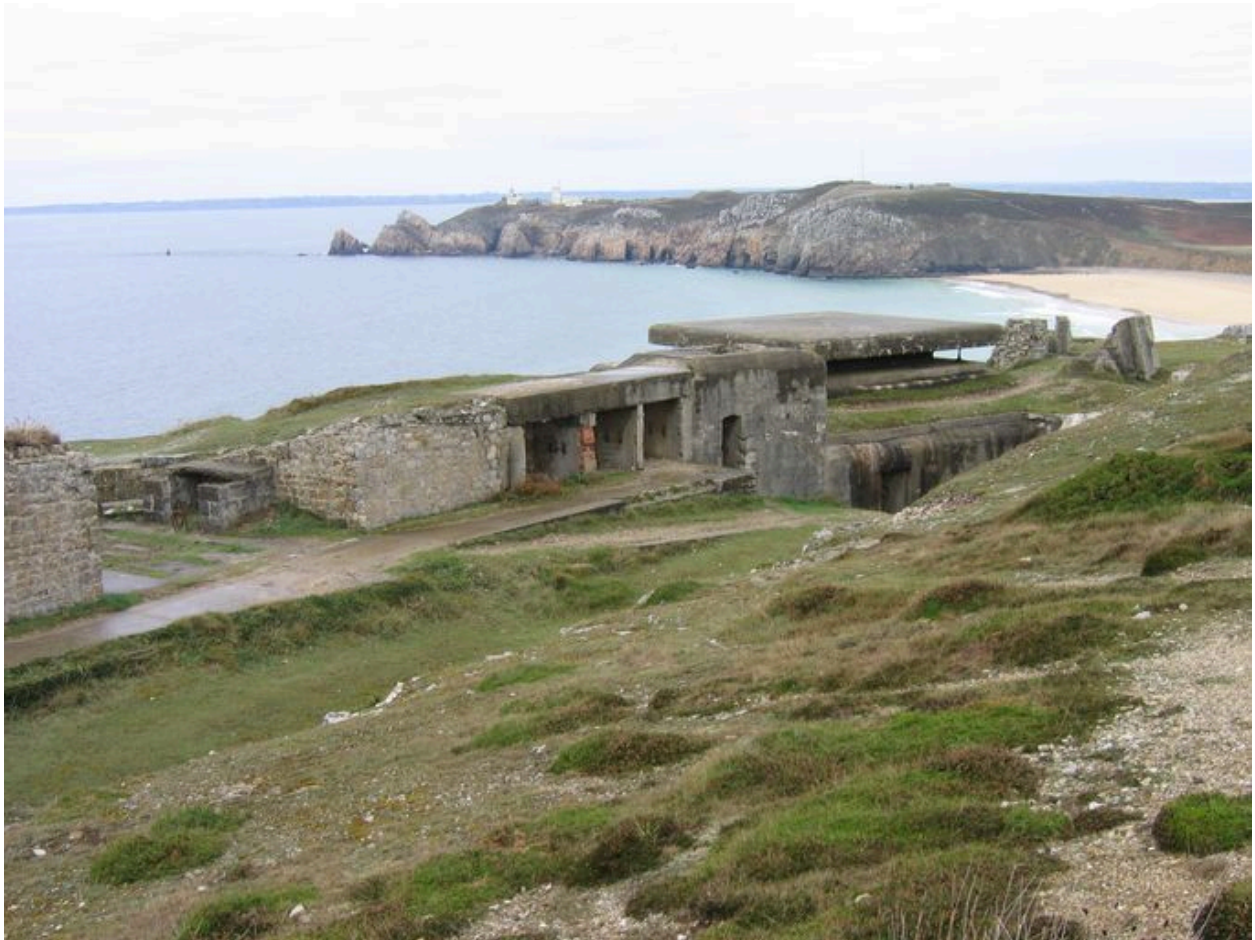
Vue générale de l'ensemble des batteries de Kerbonn
