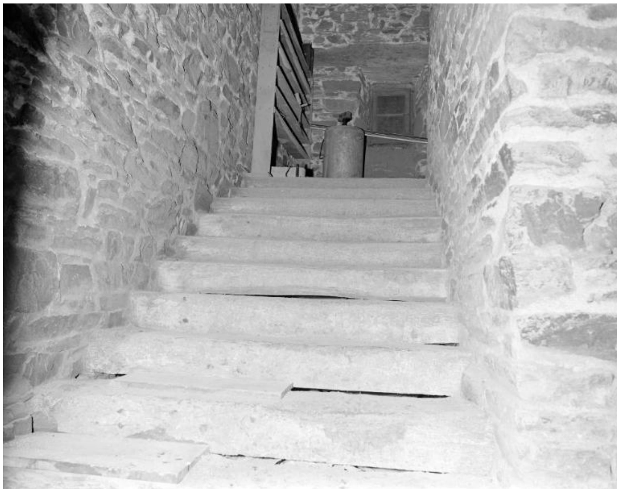
Intérieur, volée d'escalier.
