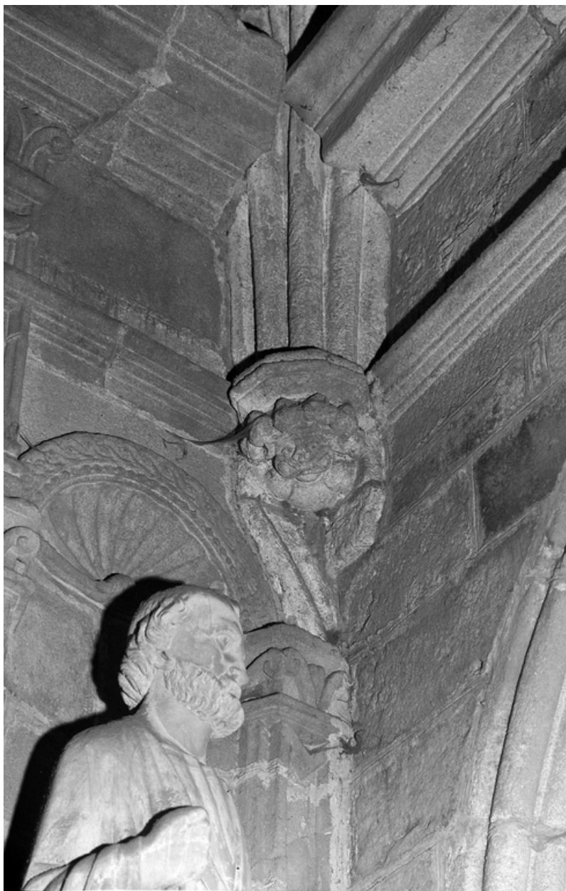
Porche sud, intérieur : angle sud est, détail du cul de lampe
