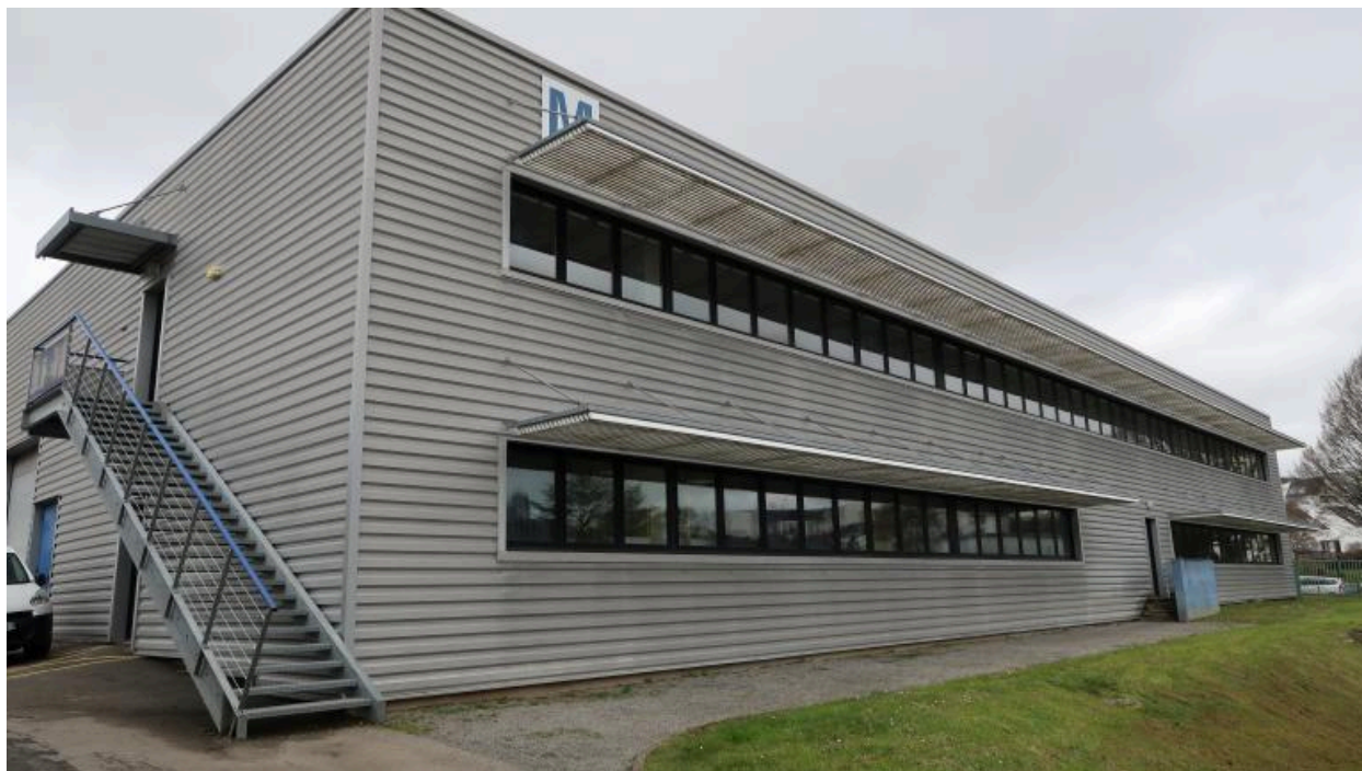
Bâtiment M : atelier automobile.
