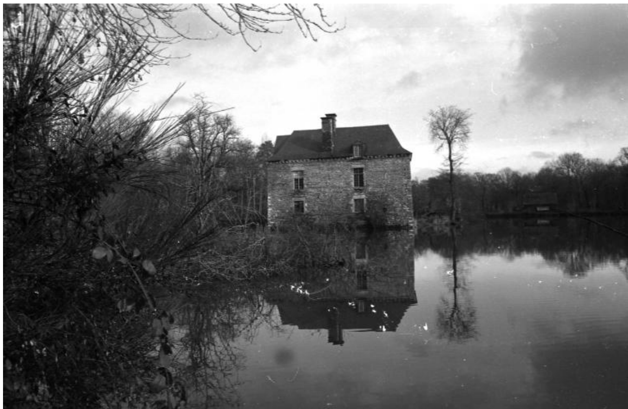
Vue de situation sud.
