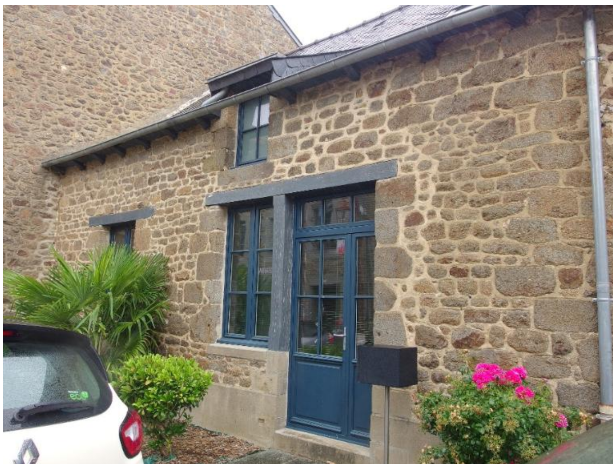
Détail de la façade ouest
