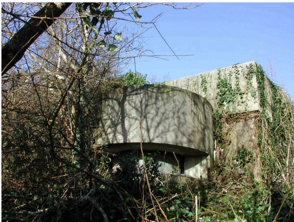
Vue de l'un des postes d'observation et de télémétrie : bâtiment n° 2 (état en 2007)
