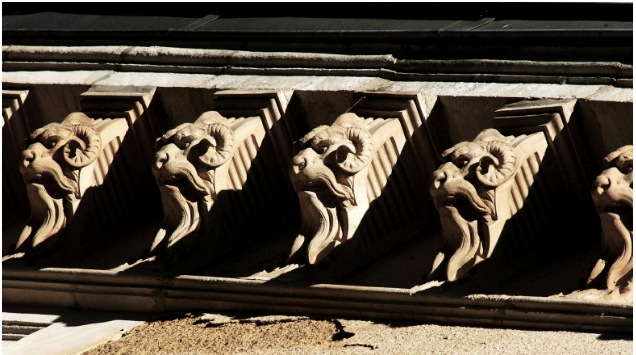
Façade sud : détail de la corniche
