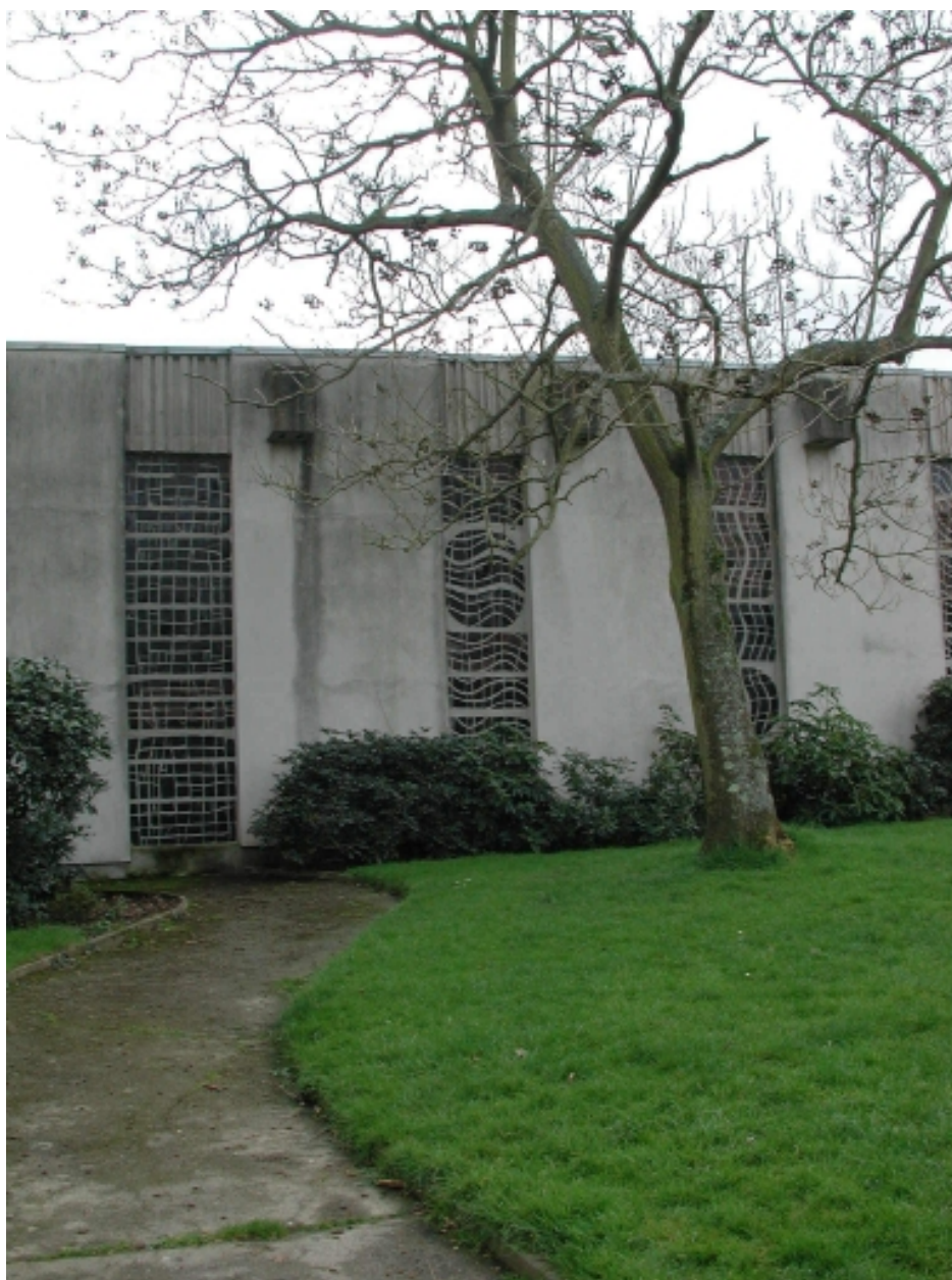
Détail des verrières de la façade nord
