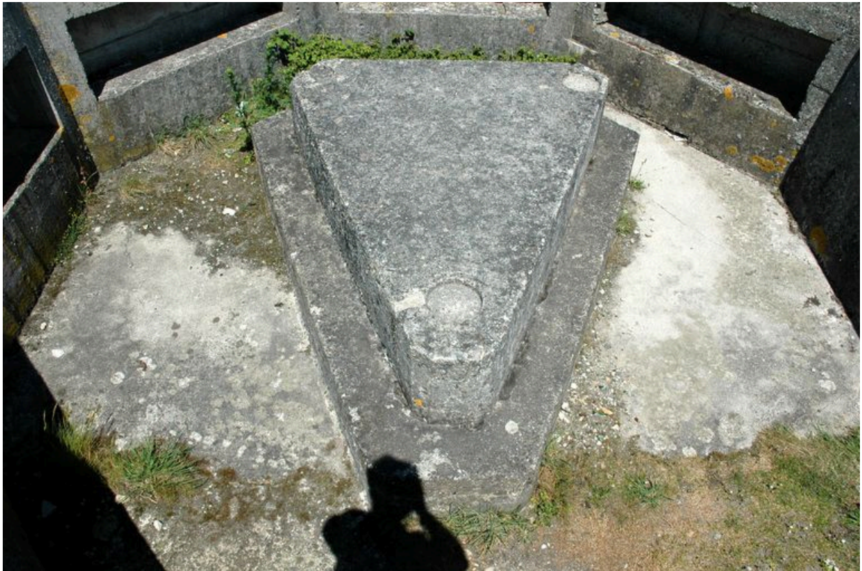
Vue d'une cuve pour canon antiaérien de 2 cm : détail du support d'affût (état en 2005)
