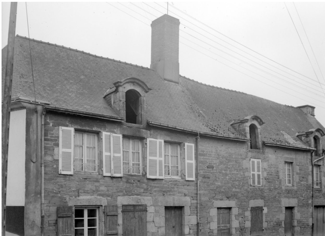
Angle des rues de la Fontaine et du Générale Kenivet, vue de situation prise du sud-ouest.
