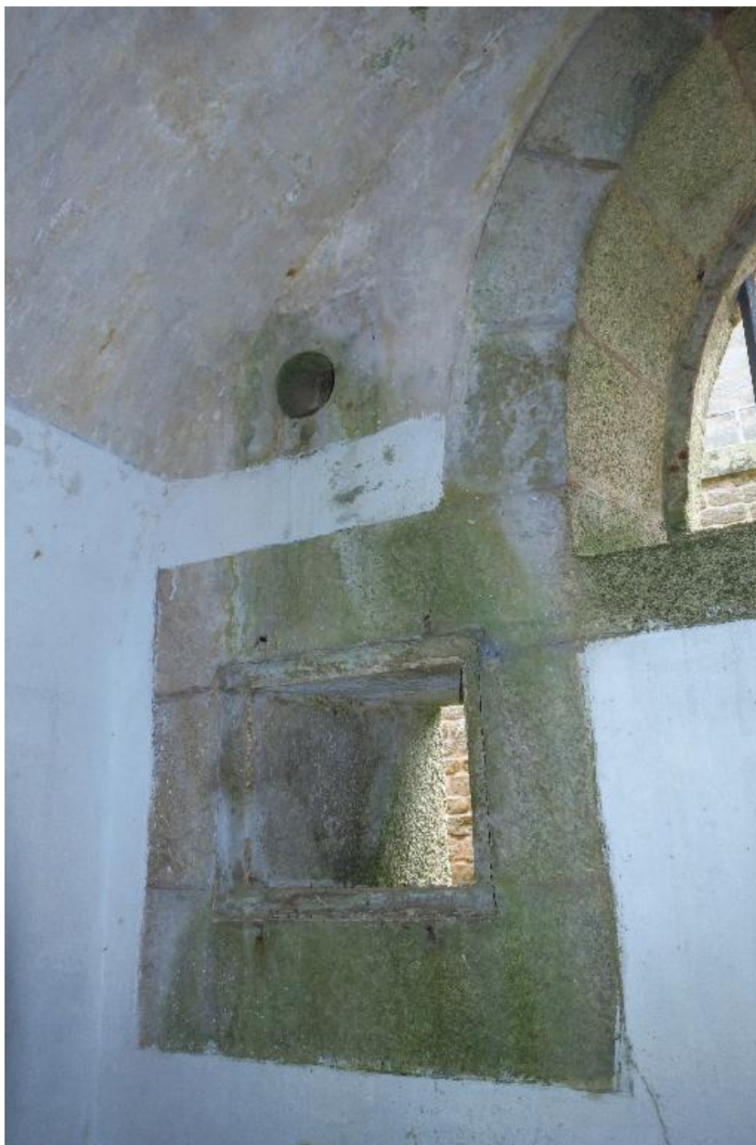
Archipel de Glénan, batterie de Penfret, corps de garde crénelé, créneau de tir et conduit de poêle dans une chambrée.
