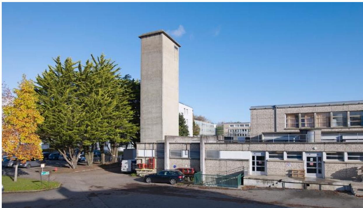
Cheminée de la chaufferie et service de restauration, détail de la façade sud-ouest.
