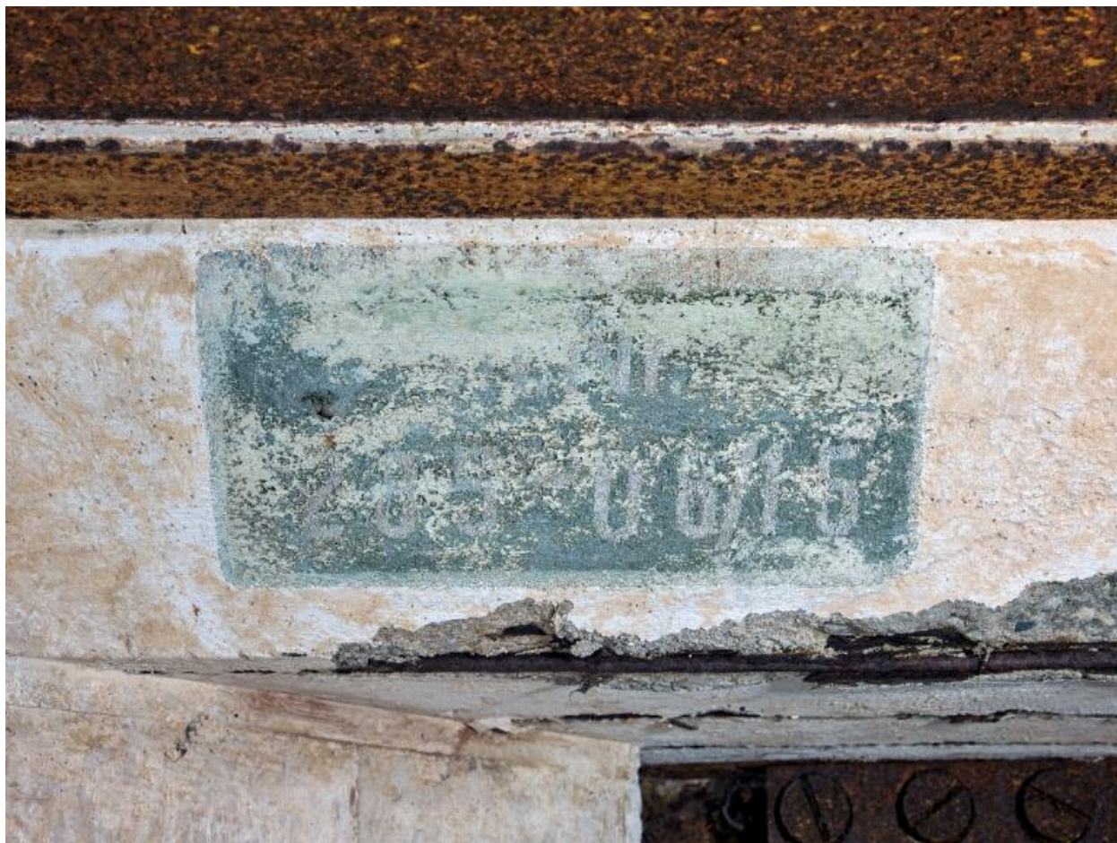
Vue de la chambre de combat nord : l'un des deux cartouches avec marquage
