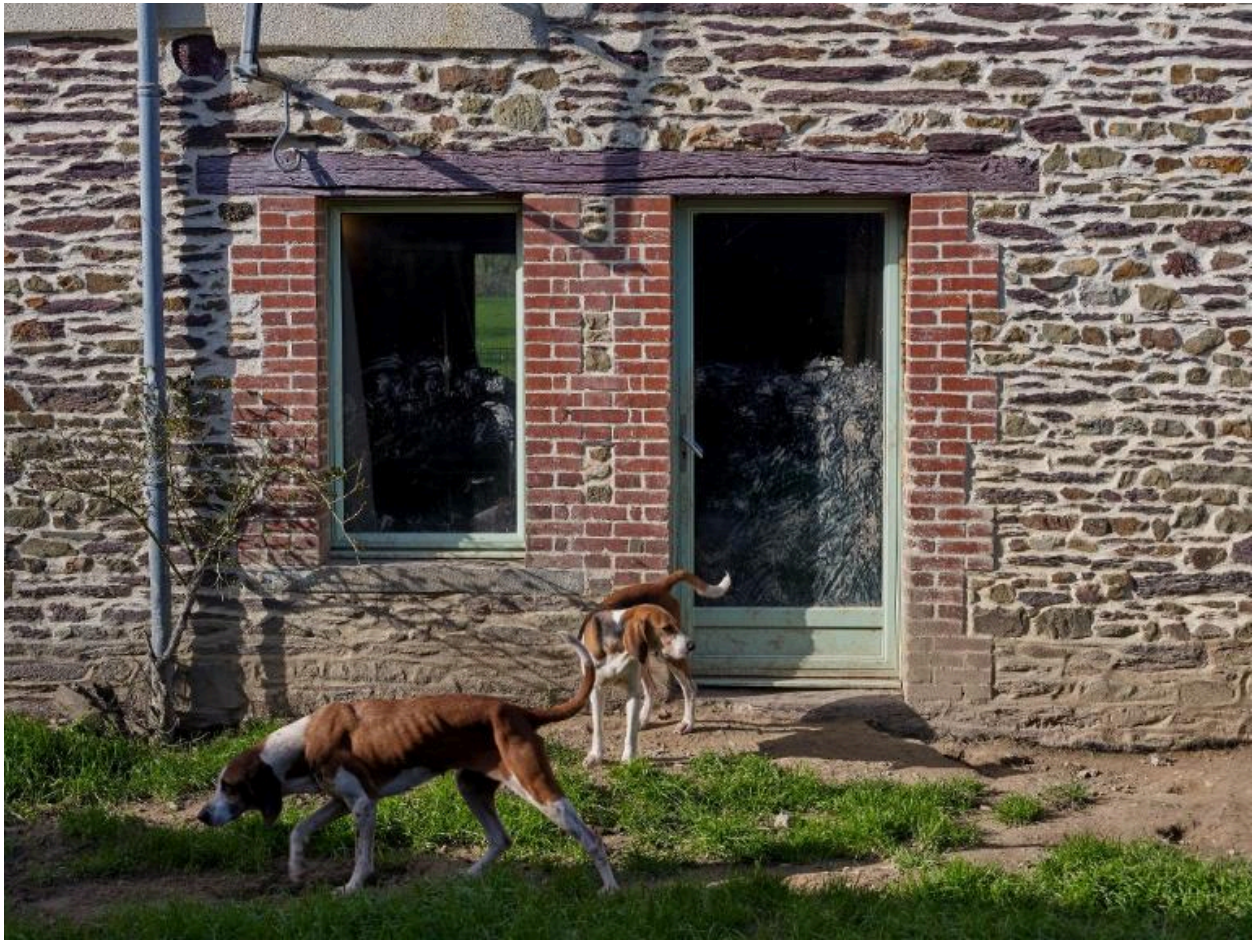
Vue de détail des ouvertures en briques
