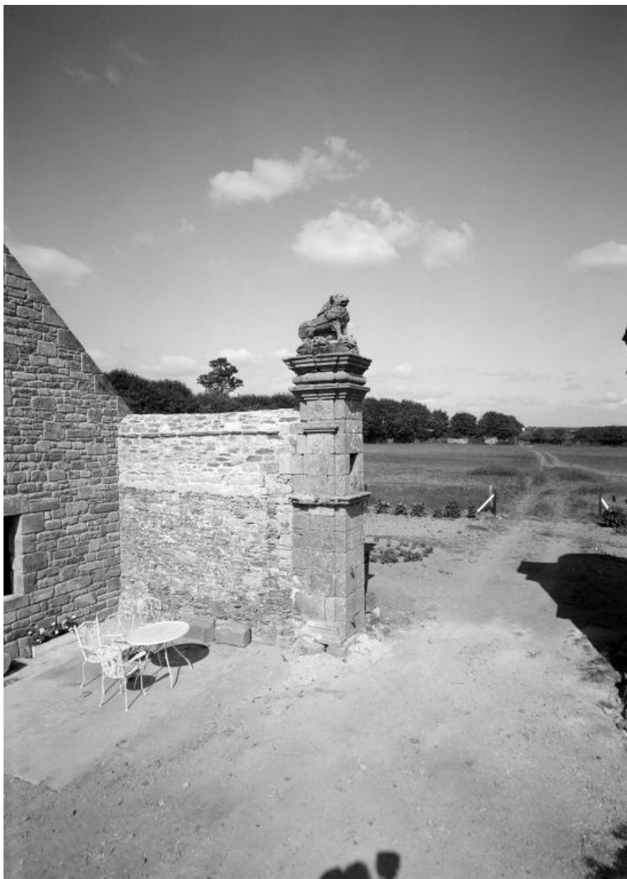
Vue d'ensemble du pilier nord du portail est
