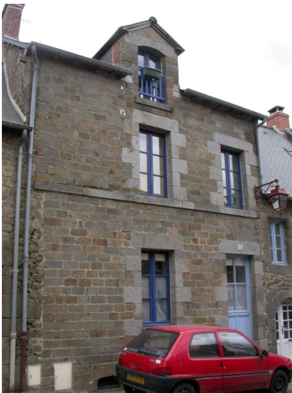
Vue générale nord
