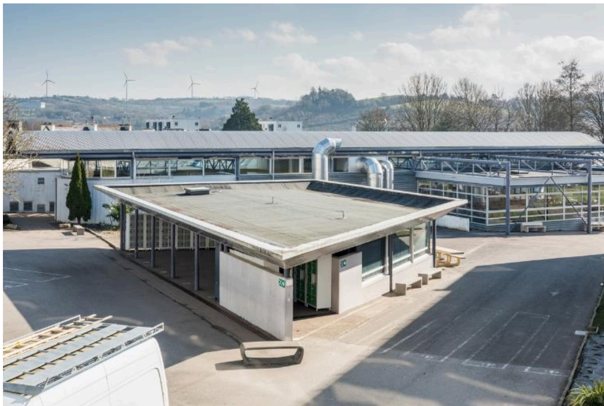
Vue d'ensemble du service de restauration. Paul Ruelland et Michel Quéré, architectes, 1989 et 1994.
