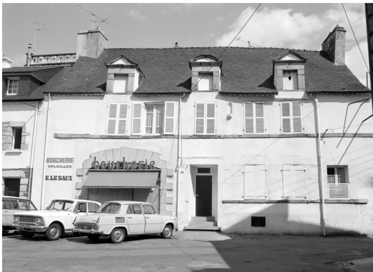
16 place Bisson, vue générale façade ouest.
