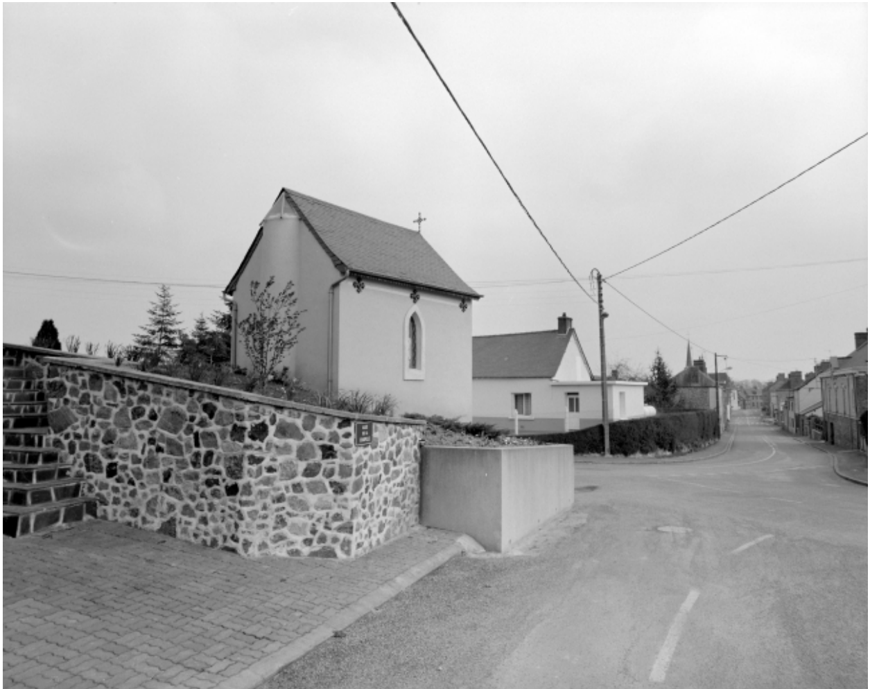
Elévation Sud : vue générale
