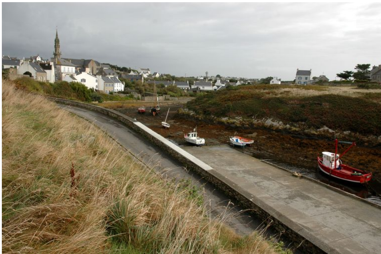
Vue du port-abri de Lampaul
