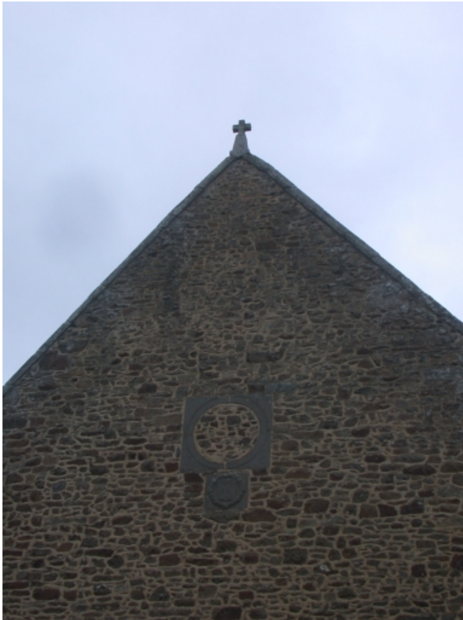
Façade Ouest, vue actuelle, détail pignon
