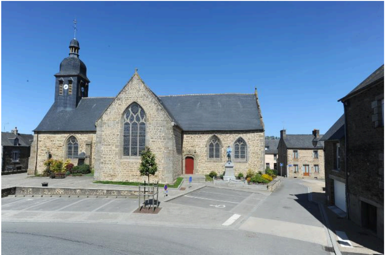
Vue générale : côté Sud
