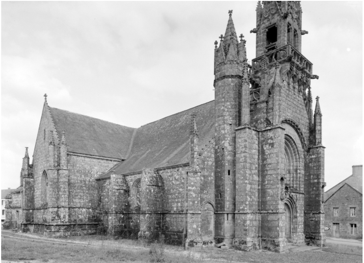
Vue de l'angle nord-est avec la tourelle d'accès au clocher.
