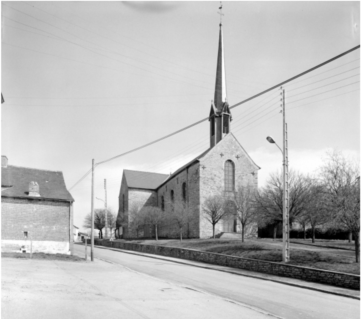
Elévation Nord-Ouest : vue générale
