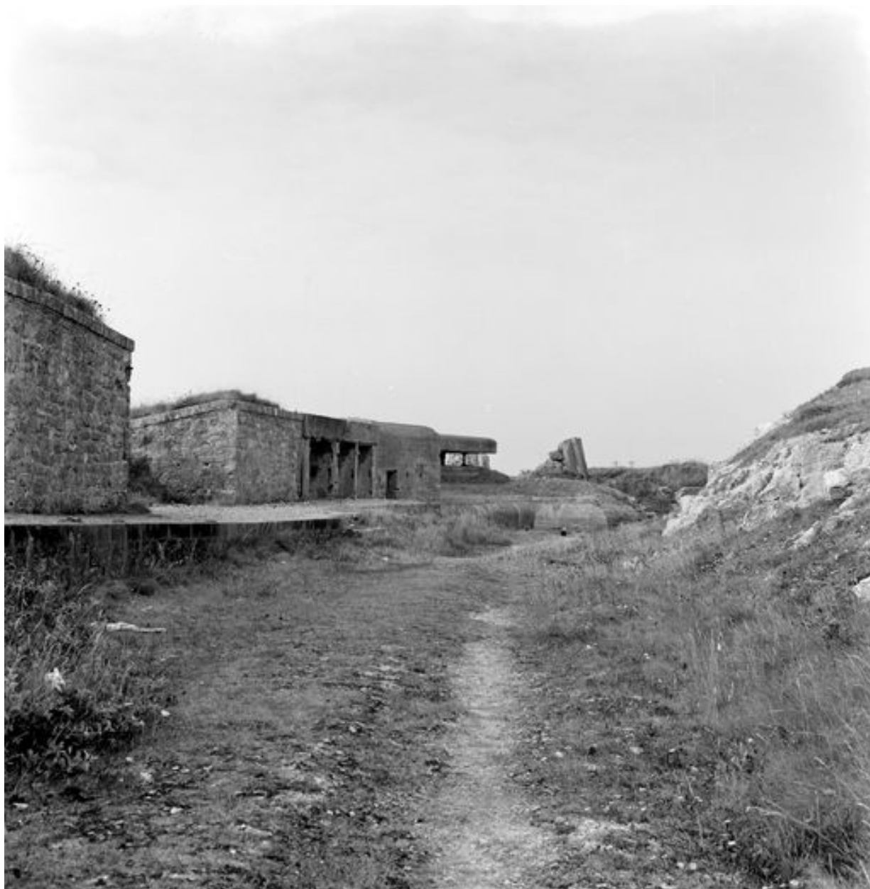
Vue de la batterie de mortier en 1969 : plates-formes de tir à ciel ouvert et traverses-abris. A l'arrière-plan, le bunker - poste de direction de tir de type M162a
