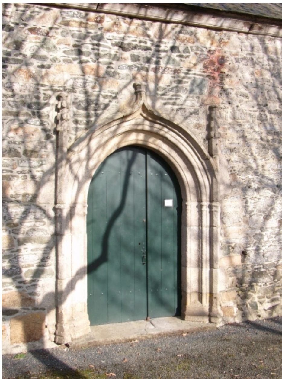
Chapelle, mur sud, porte remployée
