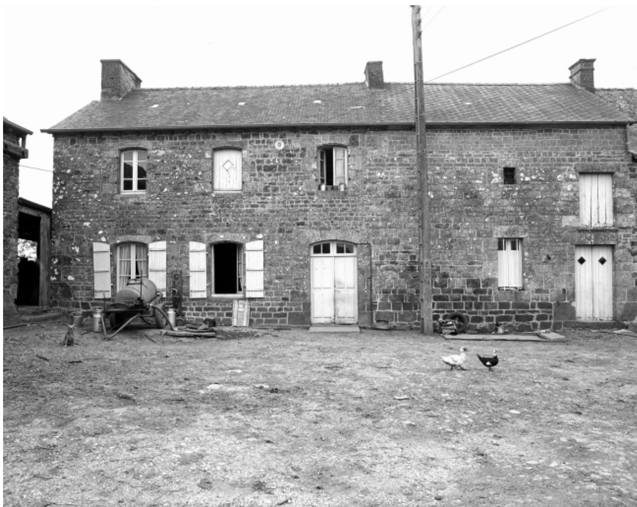
Logis 1817, vue générale.
