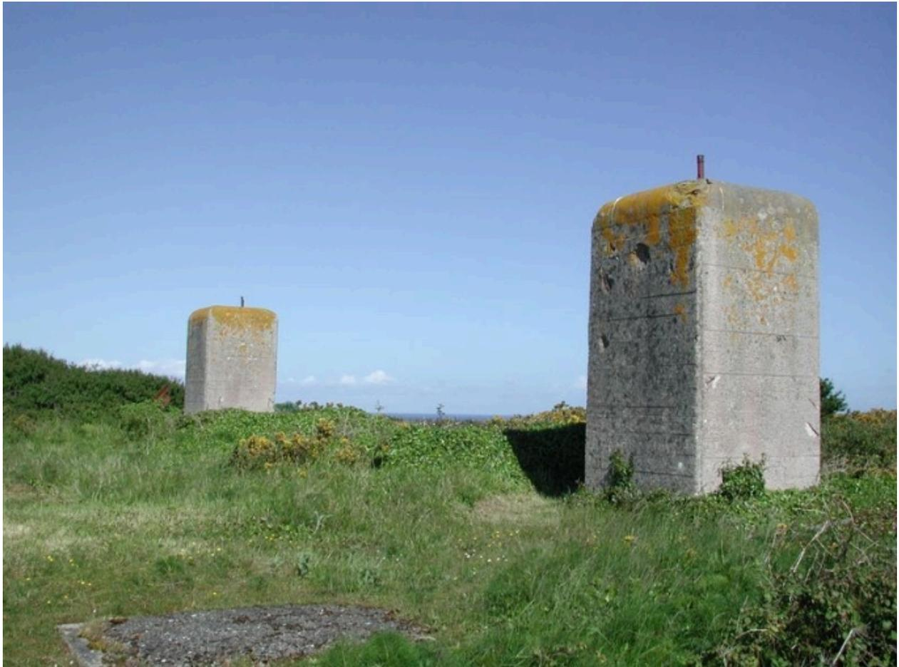
Vue générale des supports de radar Mammout (blocs verticaux comportant les 24 tubes de descente d'antenne)
