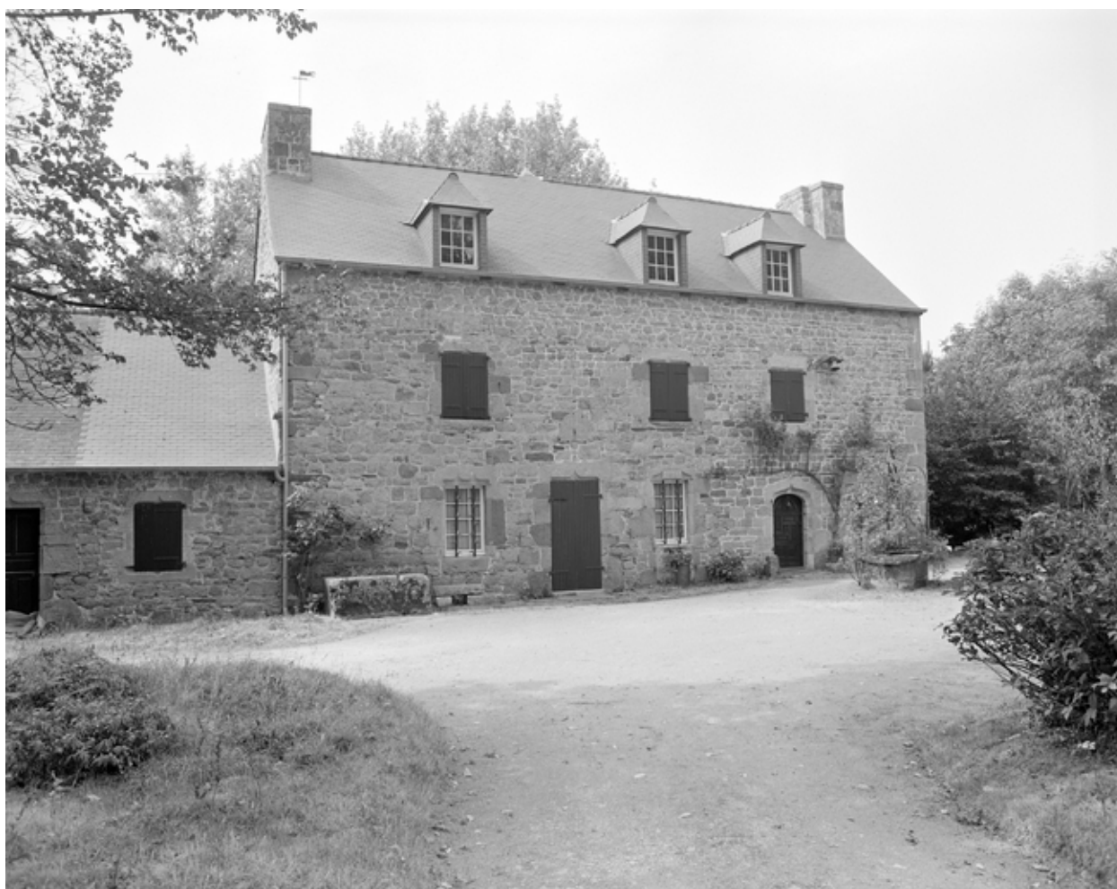
Façade antérieure : vue générale
