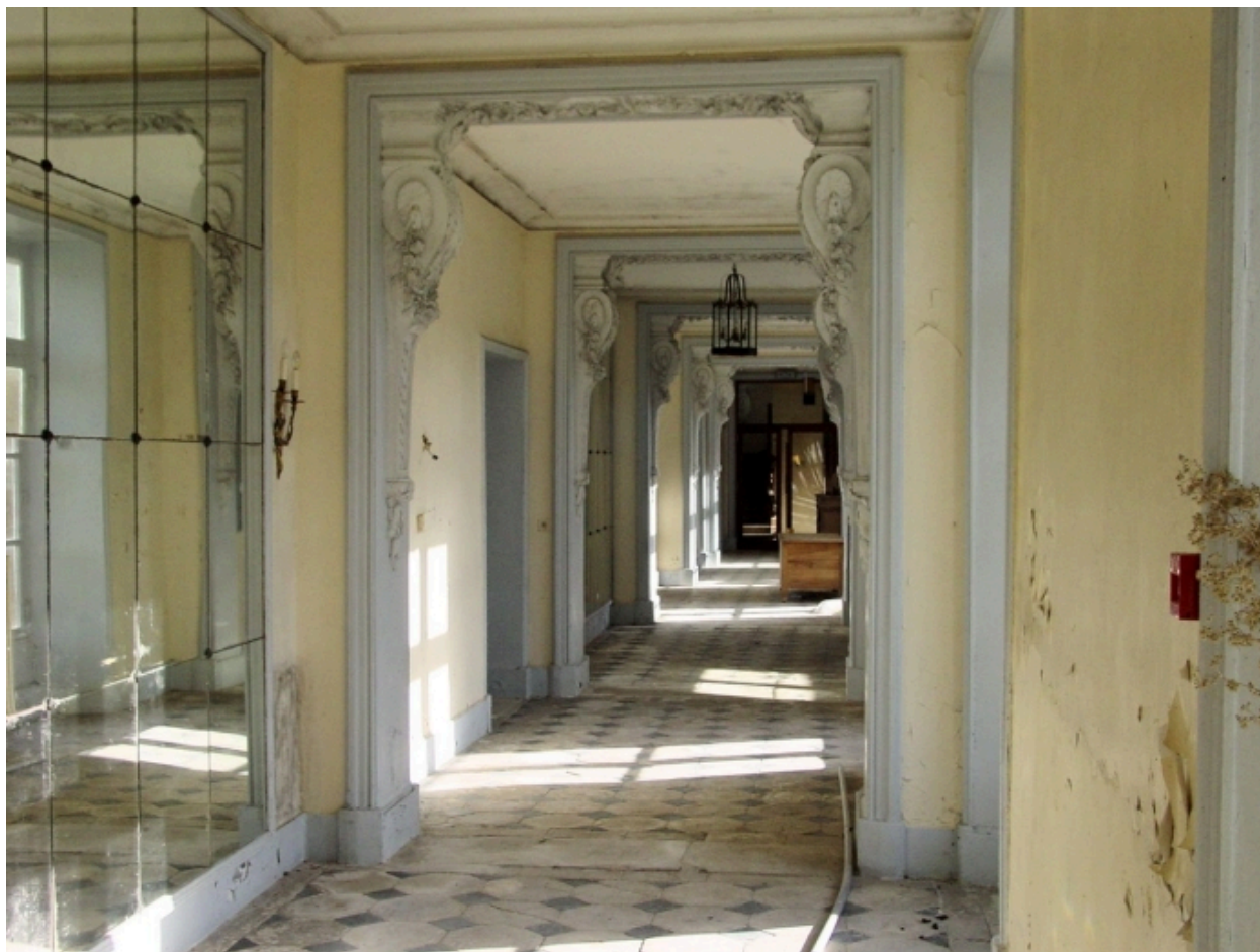
Logis principal. Galerie du RDC, vue vers le sud.
