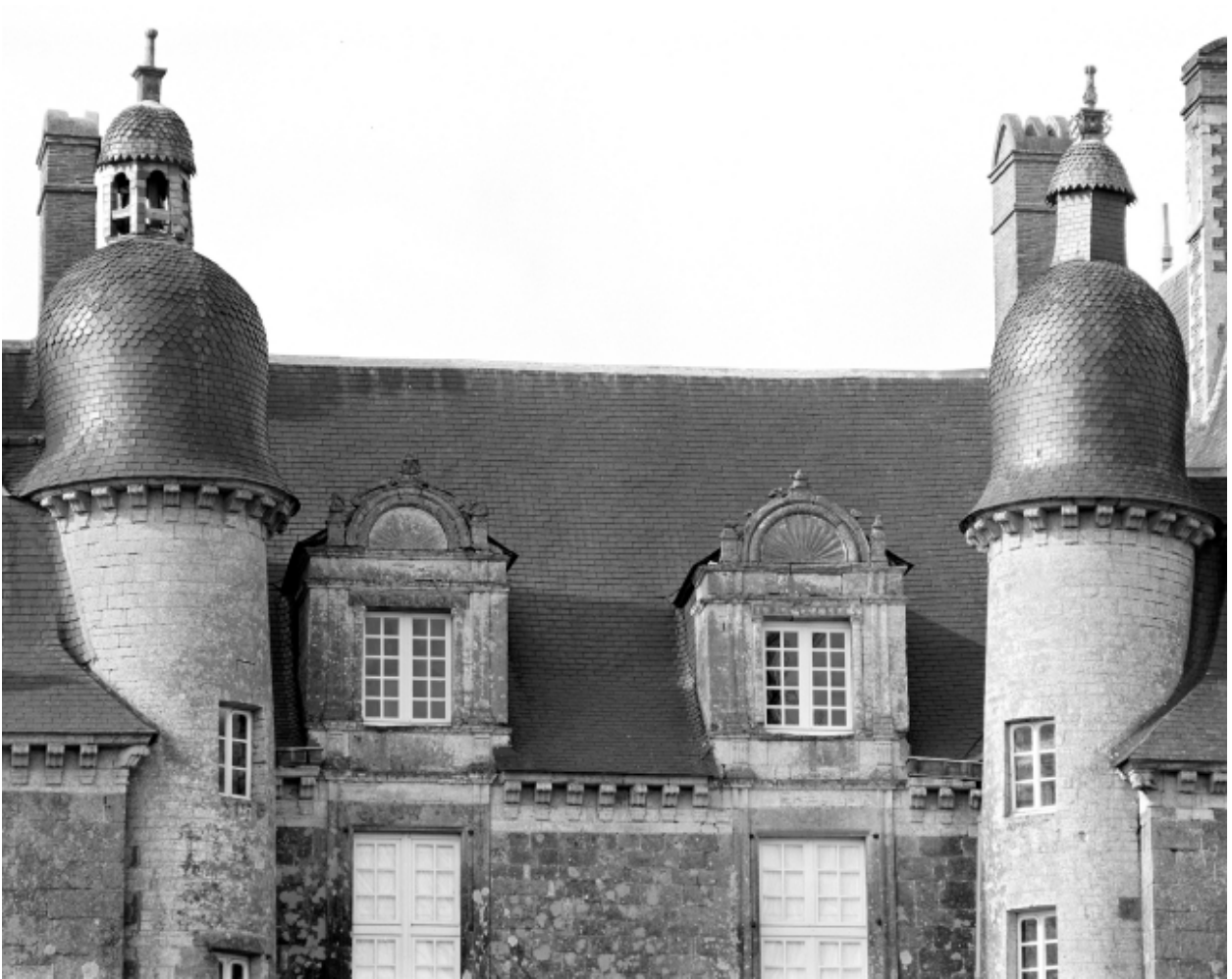
Elévation nord, lucarnes du corps central.
