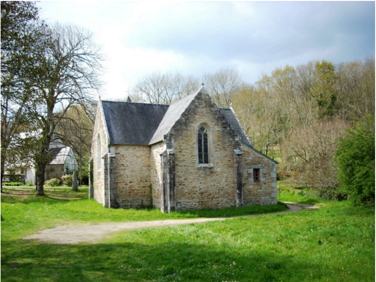
Moëlan-sur-Mer, chapelle de Lanriot : vue générale sud-est
