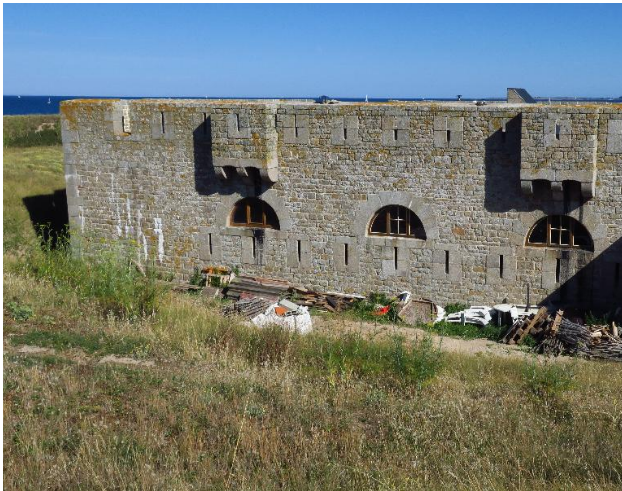
Île-d'Houat, batterie d'En Tal, corps de garde crénelé, façade nord-ouest.
