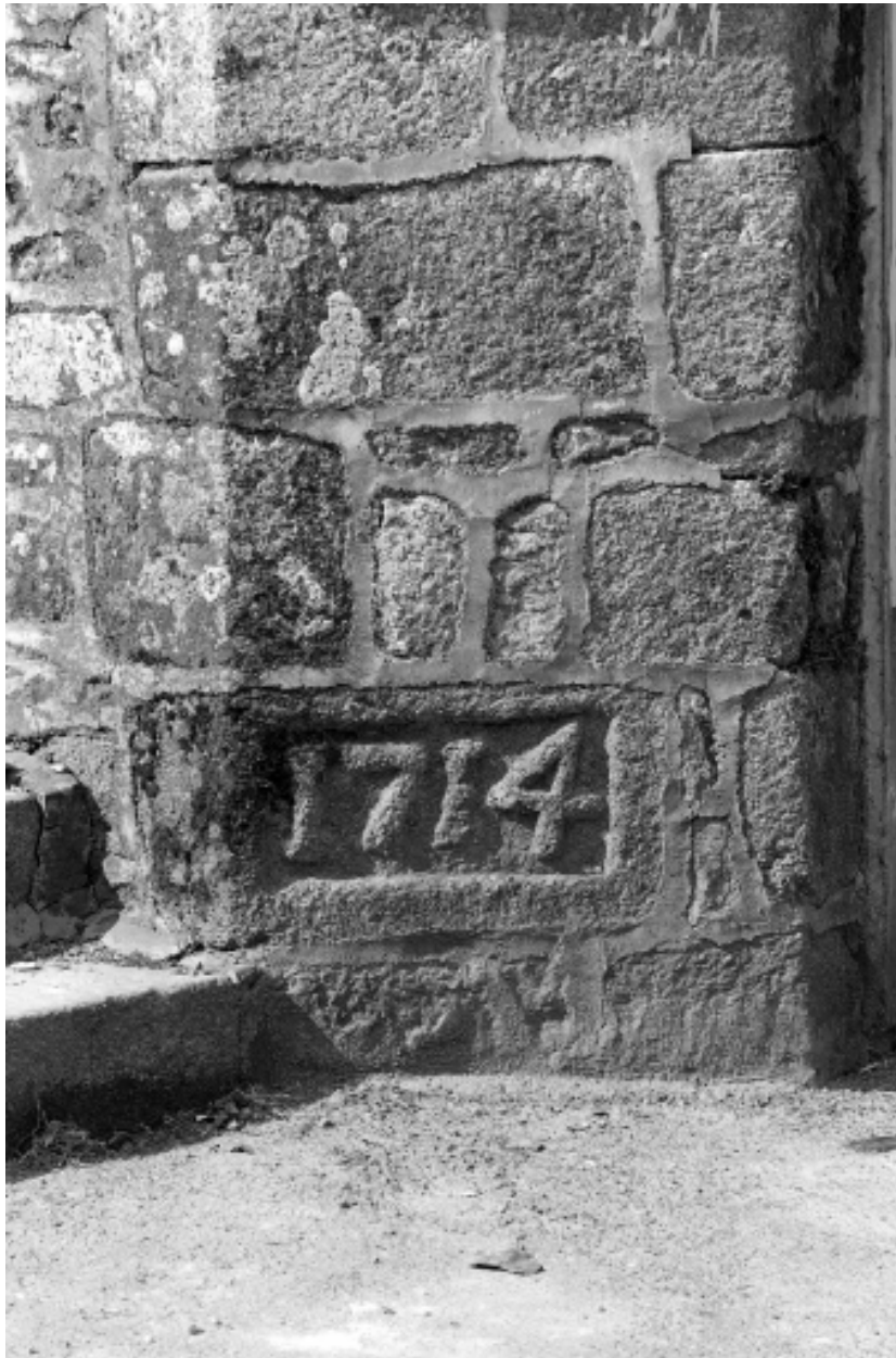
Escalier sud-est, pierre datée 1714.
