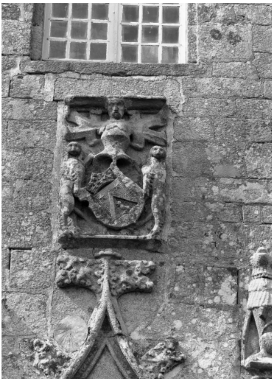
Porte de la façade sud : détail de l'écu
