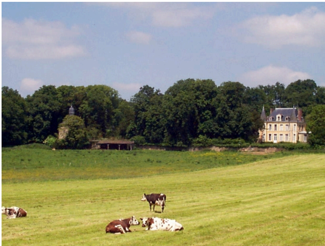
Le château et l'ancien colombier : vue de situation sud
