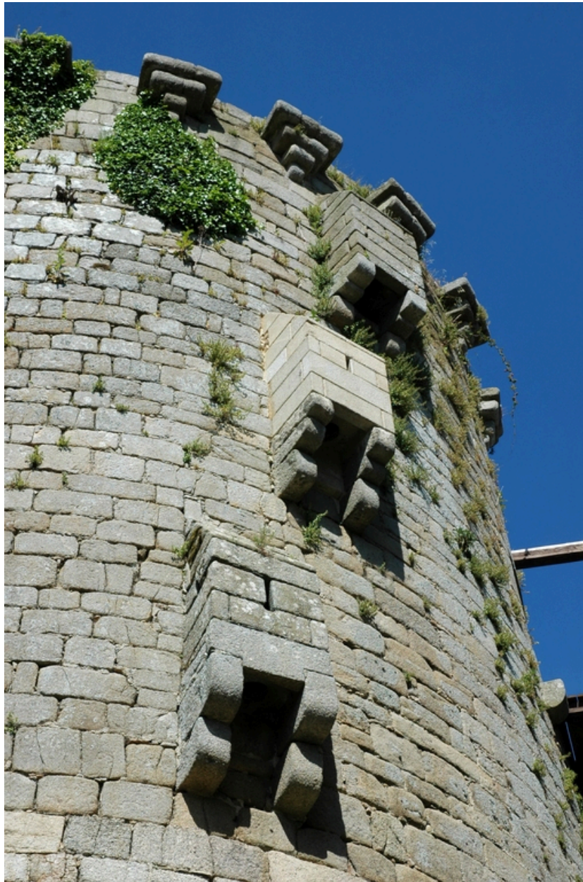
Vue de la tour nord dite dite tour de Rougé : détail des trois latrines en encorbellement
