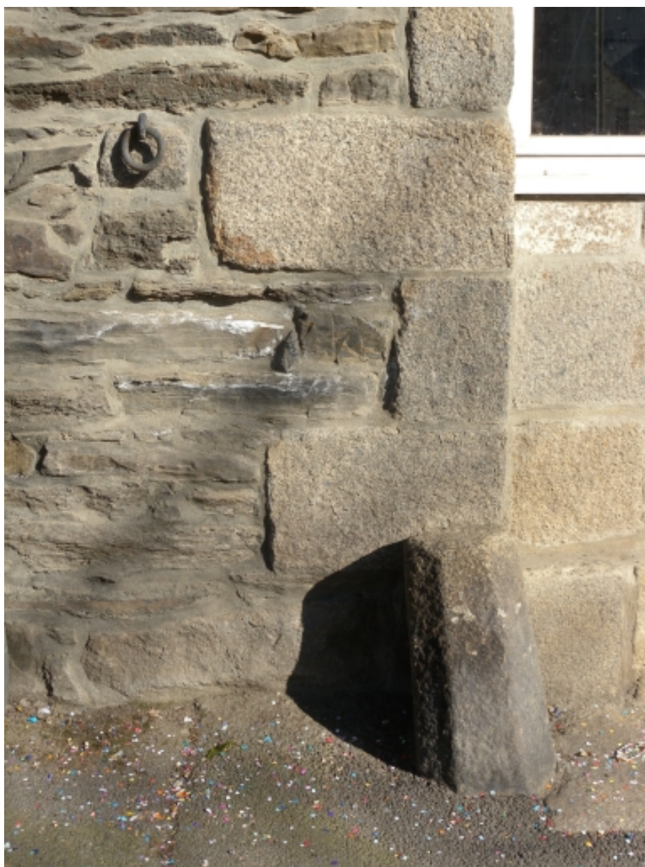
Vue de détail de l'angle antérieur droit, avec la borne de la porte cochère, les chaînes d'angle en pierre de taille et l'anneau pour attacher les chevaux
