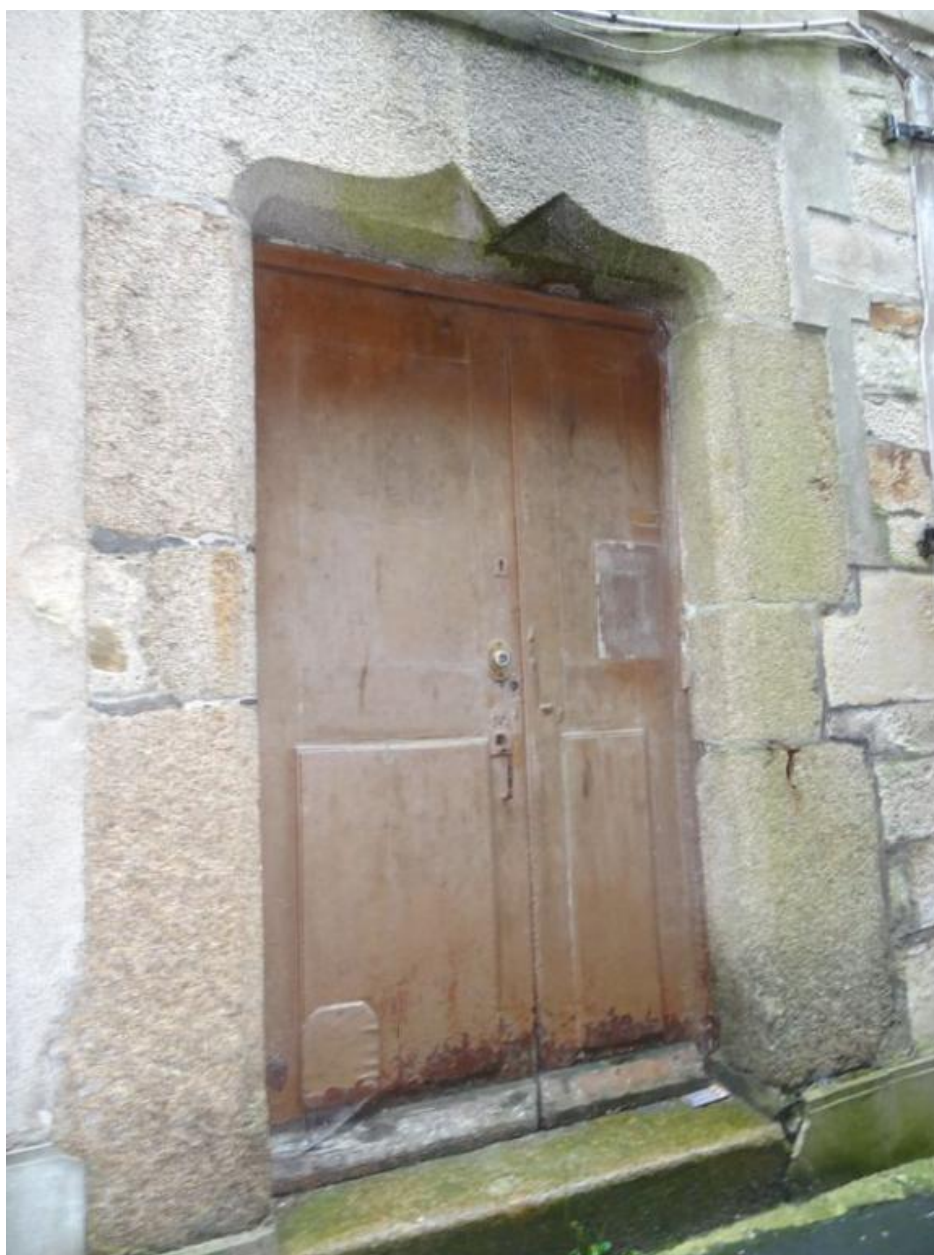
Porte du rez-de-chaussée de la façade ouest
