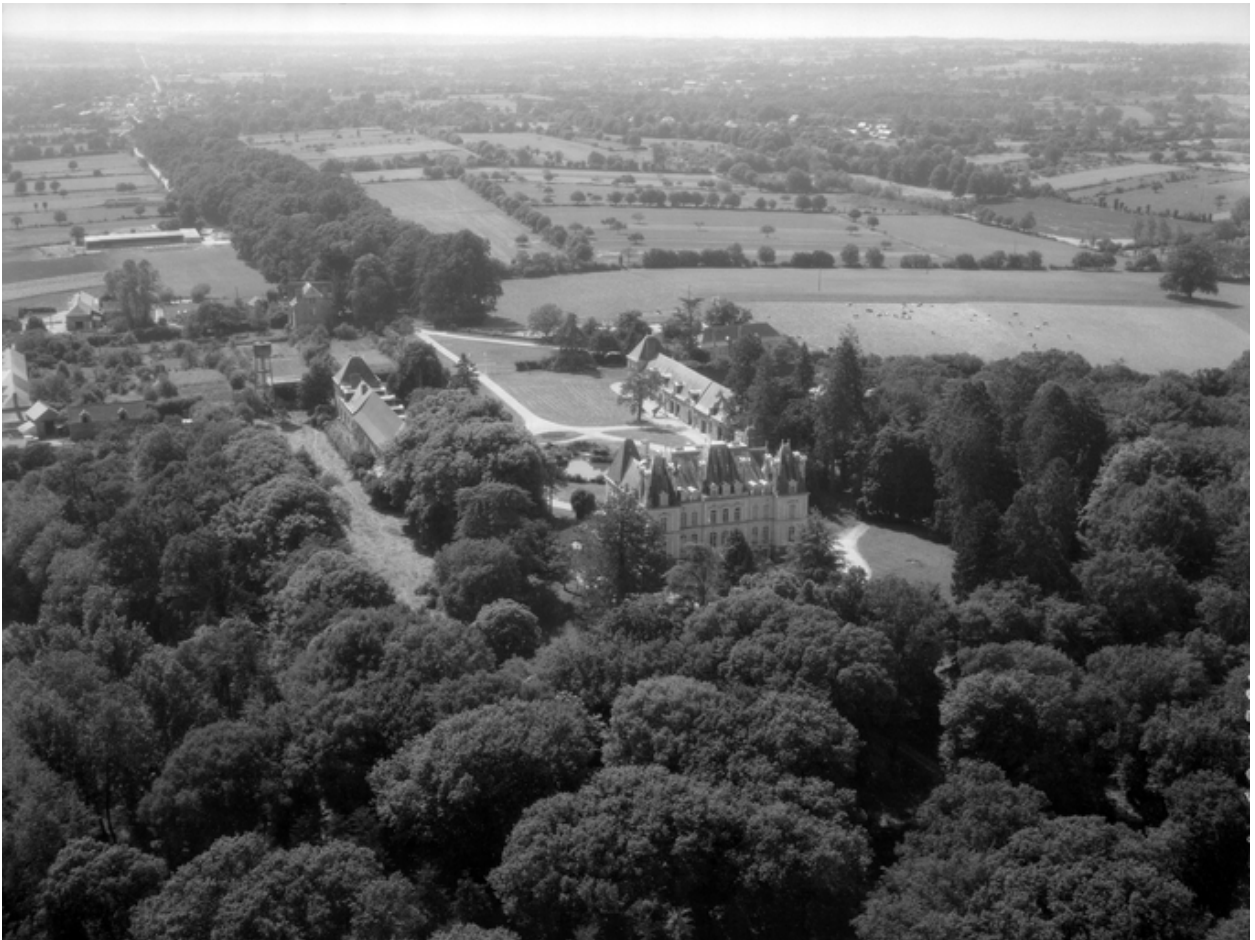
Vue aérienne nord.
