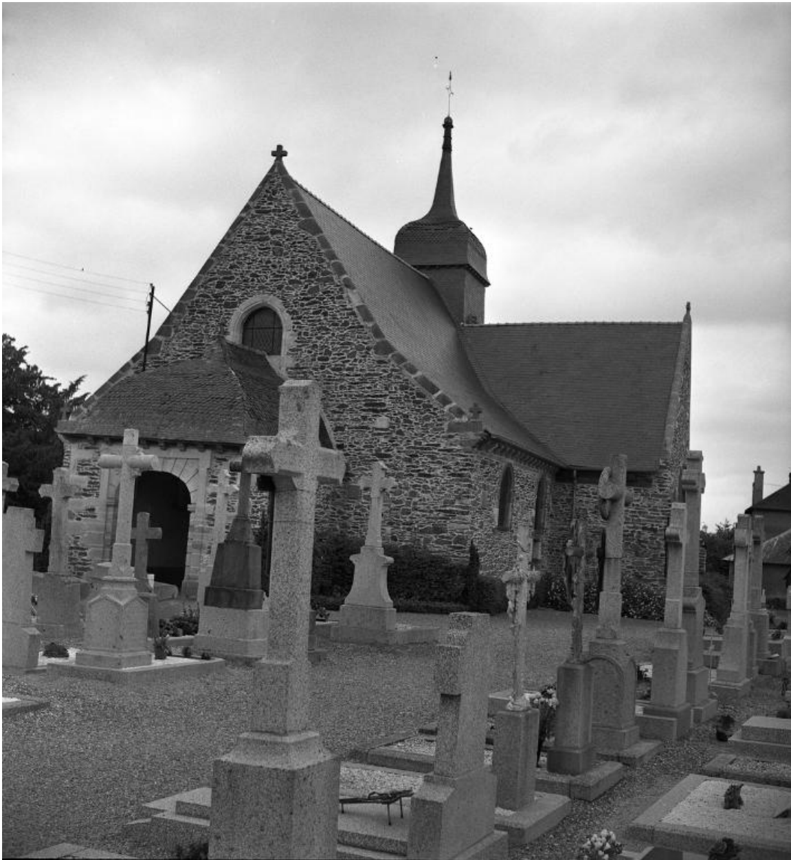
Elévation sud-ouest, vue depuis le cimetière (état en 1975)
