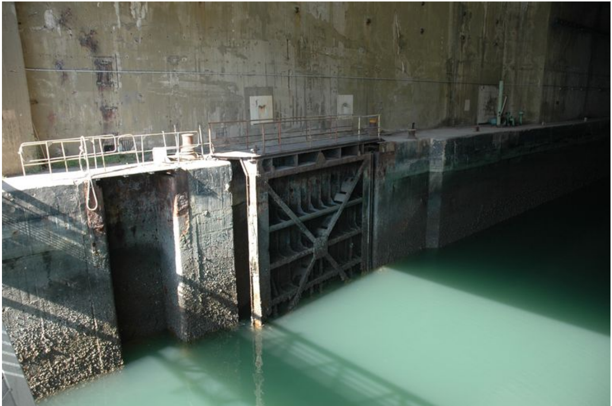
Vue de l'intérieur de l'avéole du slipway, l'une des deux portes étanches du bassin (2005)
