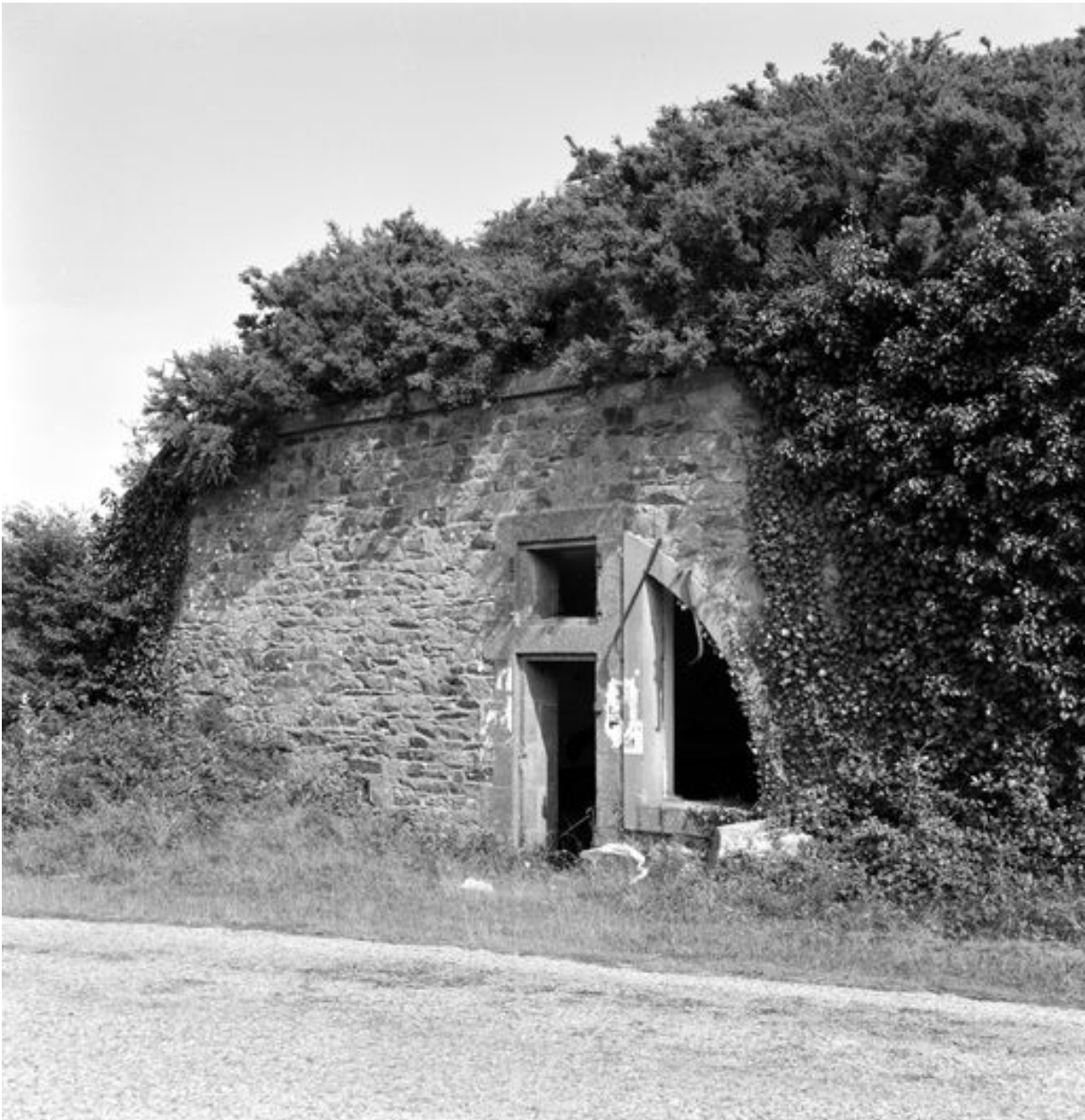
Vue de la batterie de la pointe des Espagnols en 1969 : abri-traverse de la batterie haute
