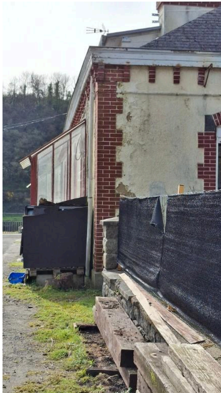
Maison éclusière, pignon nord, détail des maçonneries
