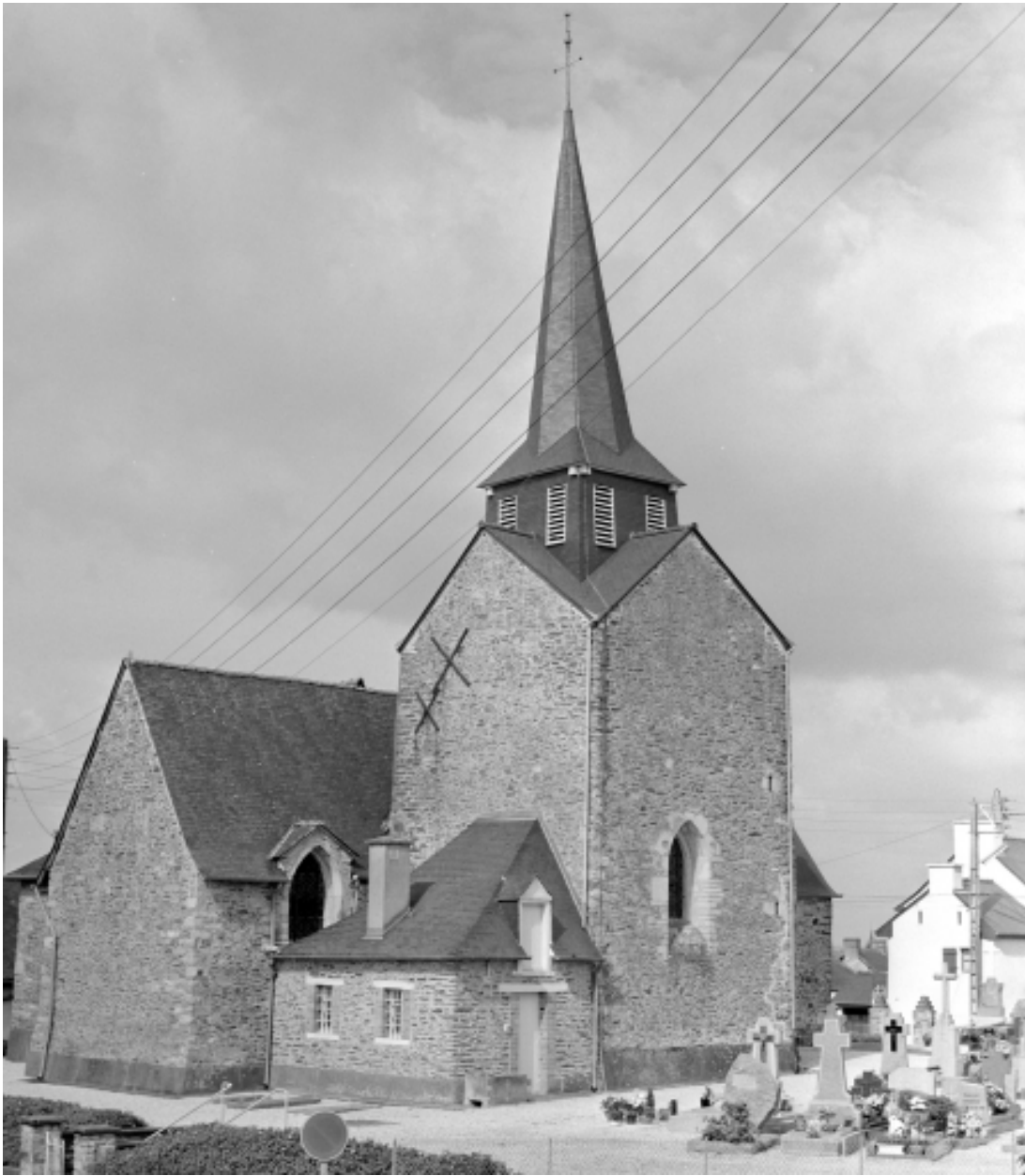
Elévation Nord-Est : vue générale
