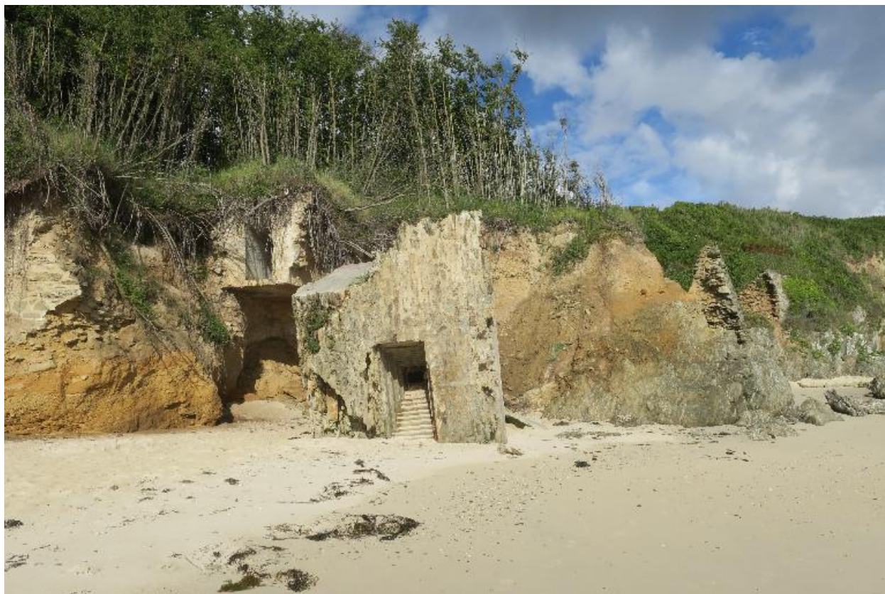
Locmaria, Grands Sables, extrémité ouest effondrée.
